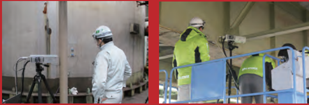
小型軽量で現場検査
