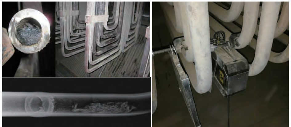
プラント配管内部をその場で確認
